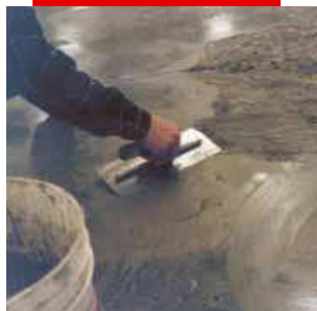
Réparation d'un sol industriel
