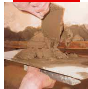
Réparation d'une allège de balcon : application du mortier
