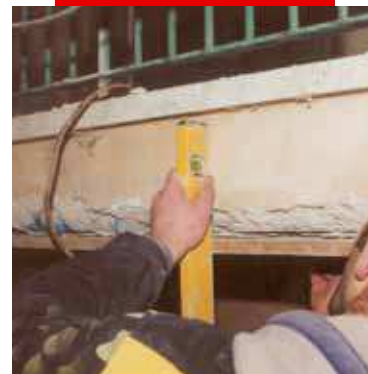
Réparation d'une allège de balcon: positionnement du coffrage
