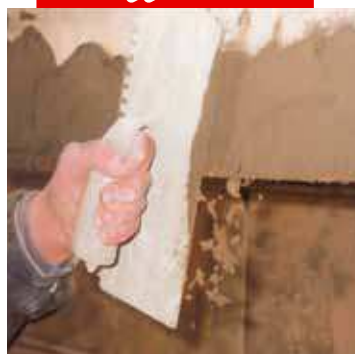
Réparation d'une allège de balcon : finition du mortier
