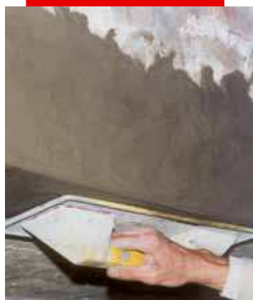
Réparation d'une poutre en béton
